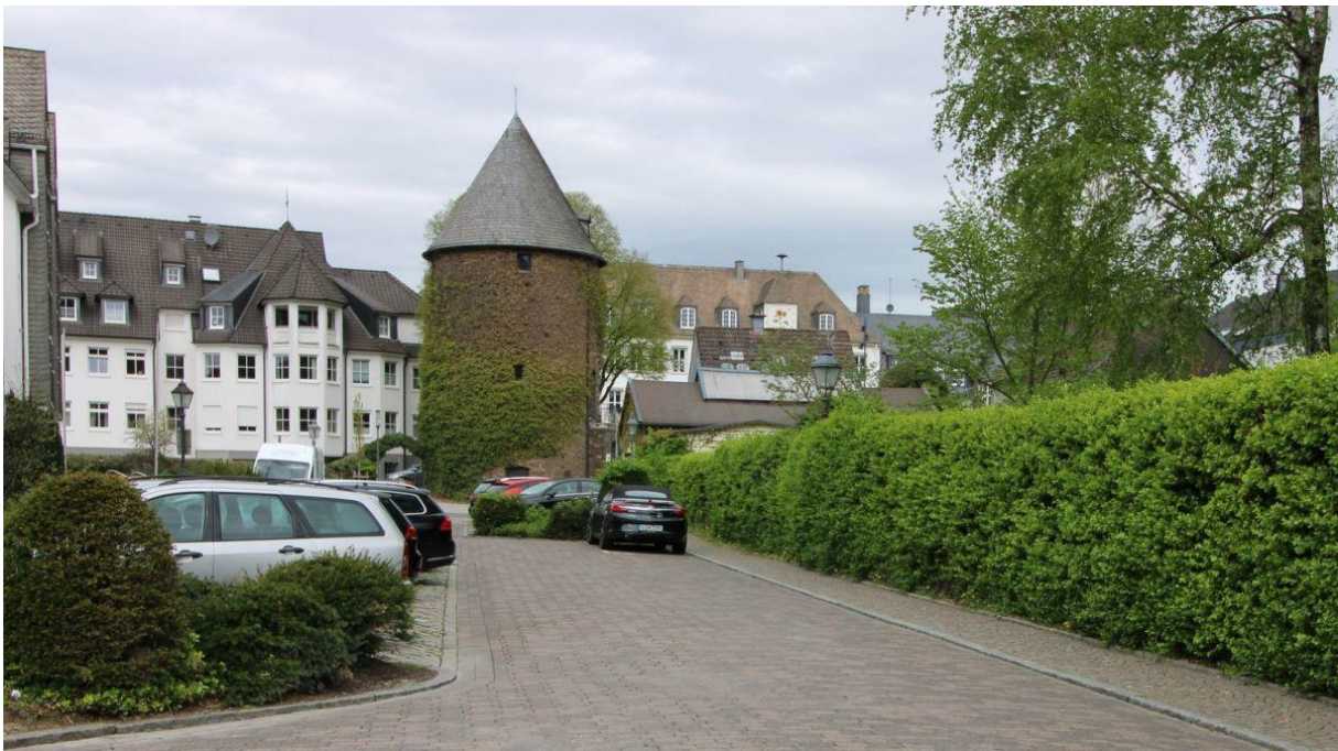
Die Bieketurmstraße wird umgestaltet.
