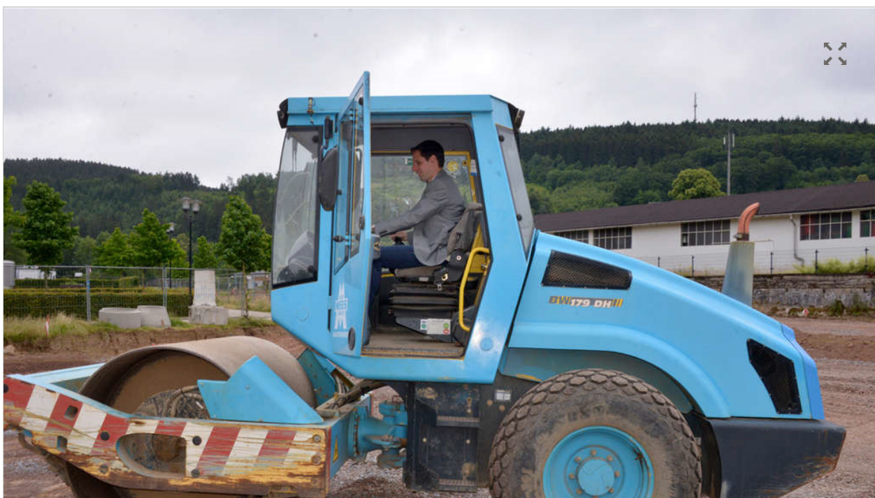
Bürgermeister Pospischil drehte „eine Runde“ mit einer Walze auf der Baustelle. © Andrea Vollmert
