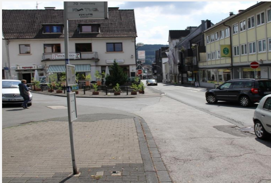
fehlende Differenzierung in der Straßenraumgestaltung (Ausbauqualität/ Querschnitt der Einmündungsbereiche)
