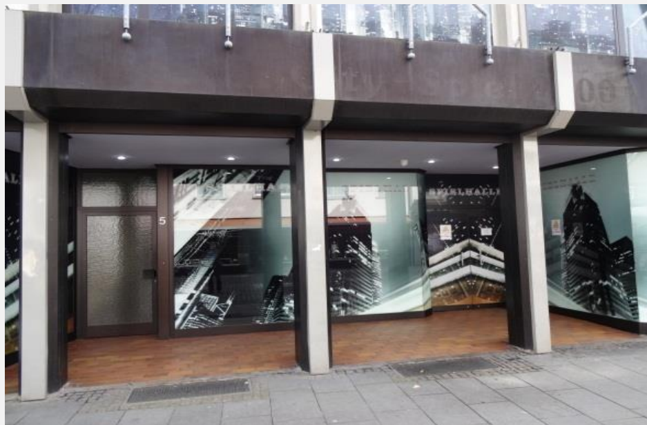
z.T. unansehnliches Fassaden-/ Stadtbild
