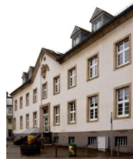
Die „Alte Post“ in Attendorn soll für 3 Millionen Euro saniert und umgebaut werden. © Andrea Vollmert
