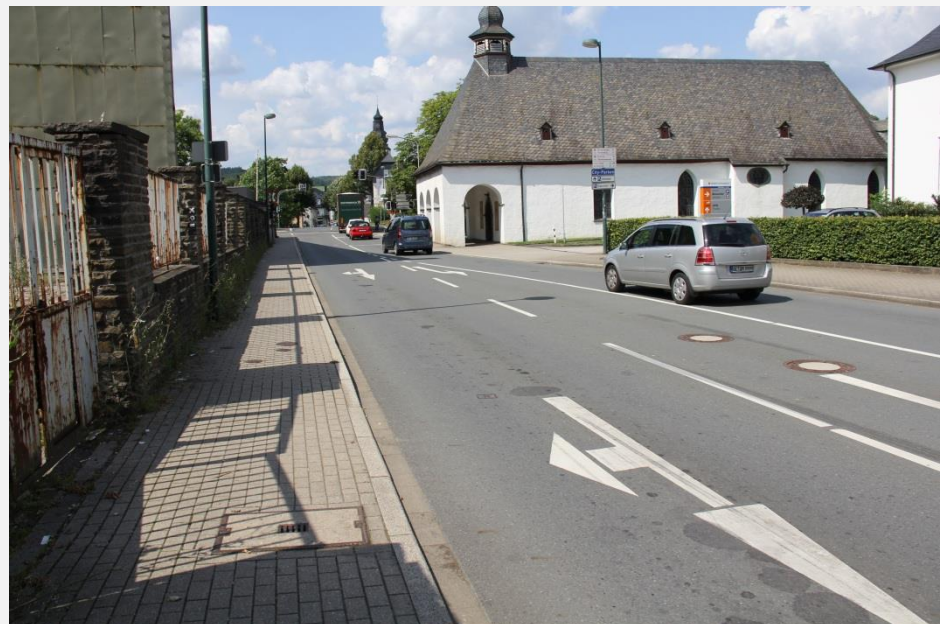
Stadteingangssituation Süd mit Blickrichtung Altstadteingang
